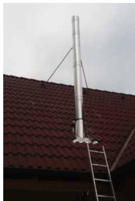
Upevnění vyšší nadstřešní části
