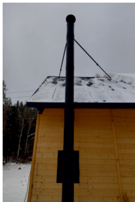
Upevnění vyšší nadstřešní části
