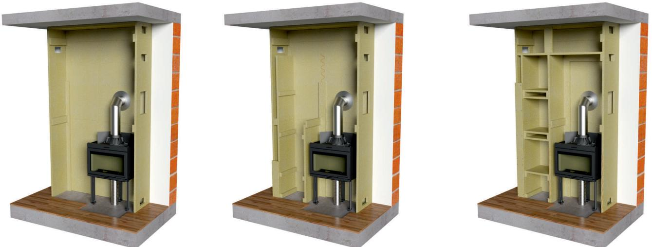
Tímto způsobem pokračujeme až do stropu. Otvor na krbové mřížky vytvoříme tak, že do desky vyvrtáme aku vrtačkou dostatečně velký otvor pro nožovou pilku. Pilku vložíme do otvoru a vyřízneme dle vyměřených nakreslených čar. Již popsaným způsob začíná stavba niky a postupné zaklápění čelní strany krbu. Byl vystavěný falešný, někdy také nazýváme dekomprezni strop krbu. Je důležitý a ČSN normou požadovaný.
