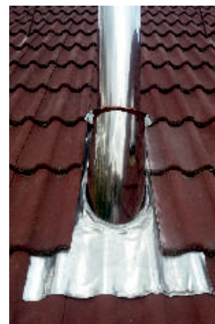
střešní olověné oplechování
