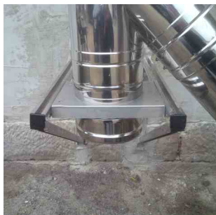
základová deska mezivzpěra
