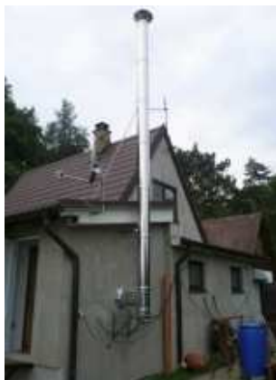
fixace vyšší nadstřešní části
