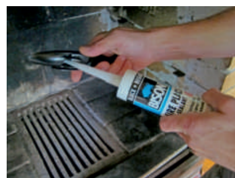
Oprava spár v topeništi
