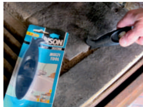
Oprava spár v topeništi
