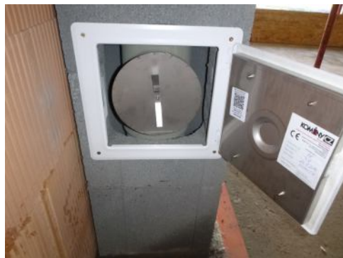
Osazení dvířkového uzávěru
