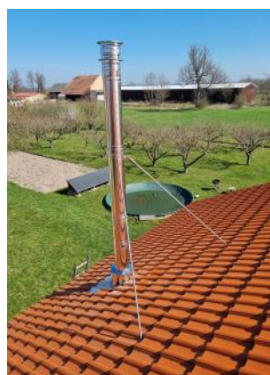
Fixace vyšší nadstřešní části
