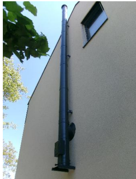
Osazení dvířkového čistícího dílu
