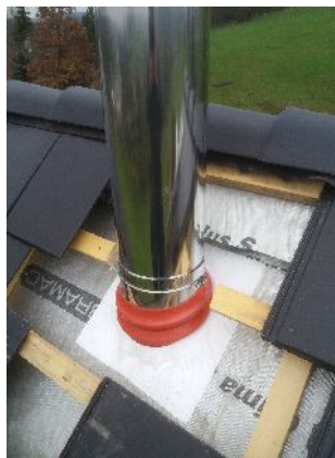
HotSchott pro napojení folie
