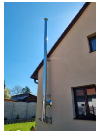
Upevnění delší držáky
