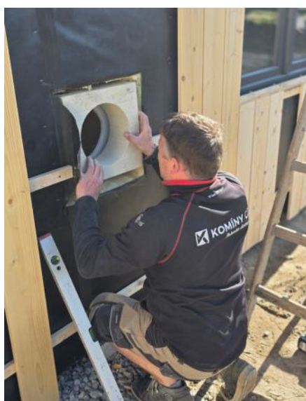
Instalace bezpečné průchodky
