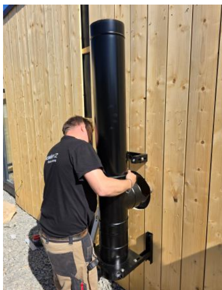
Instalace držáku
