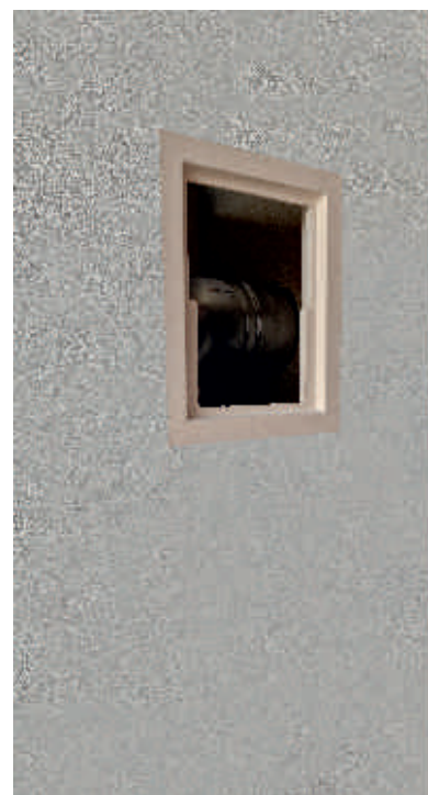
Detail revizního otvoru
