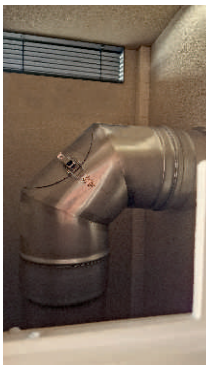
Detail zadního napojení na komín
