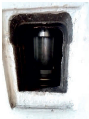
Osazení čistícího prvku
