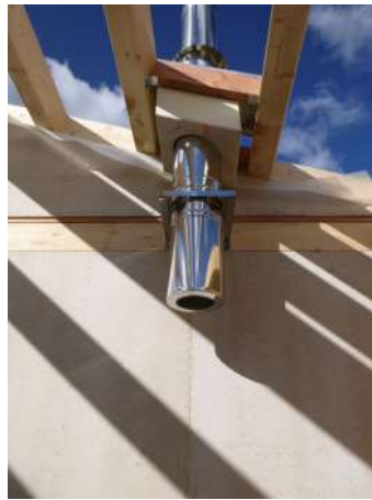
Systém Nerezo 3V kouřovod s funkcí komínu
